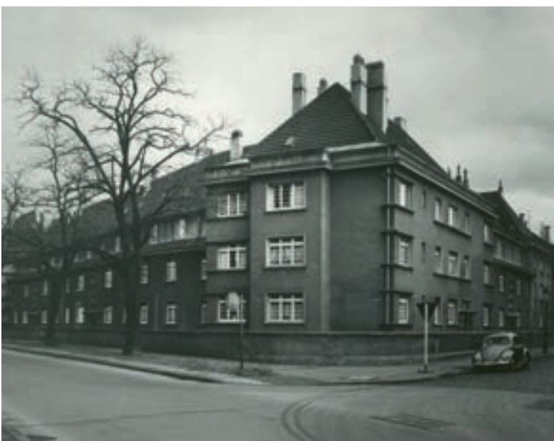
Kerpener Straße, Leichtensternstraße
