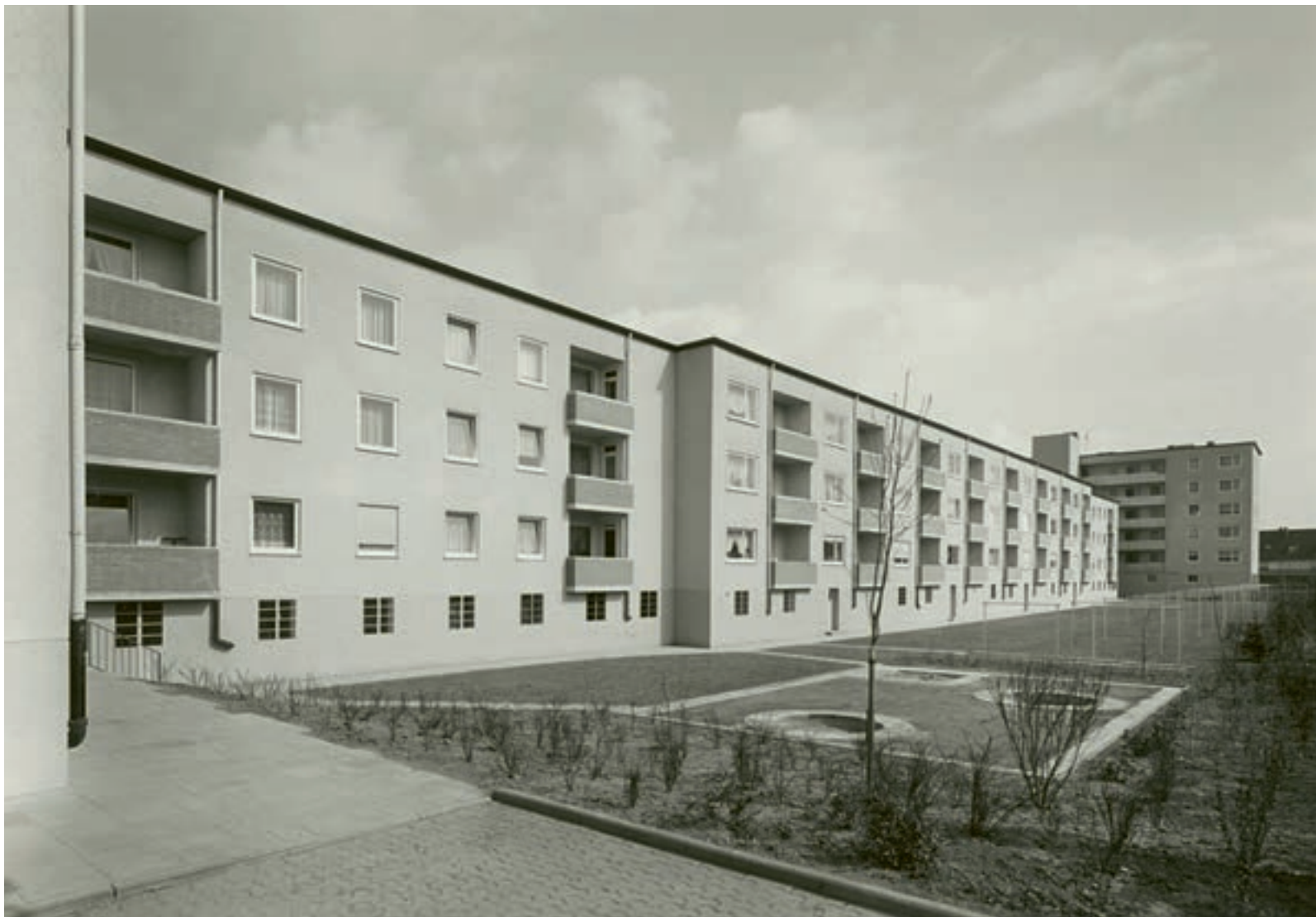
Kösliner Straße 1–15, Hof / Neubau, Baujahr 1967
